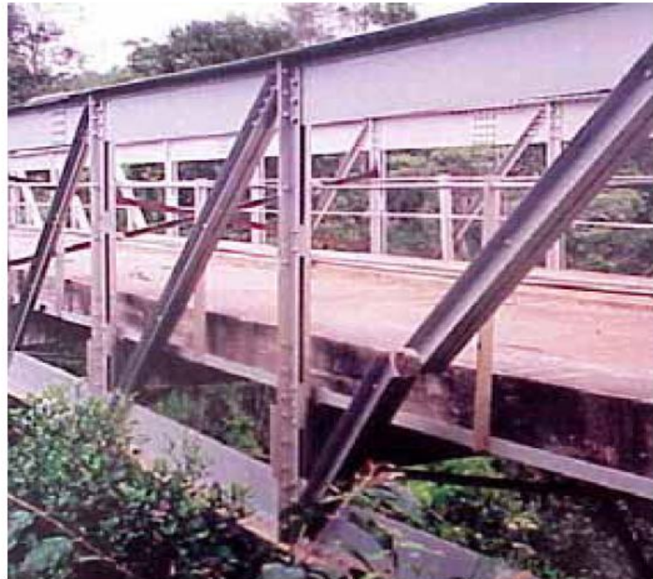
Fig. 21 : Rupture d'une diagonale tendue sur un point de soudure
