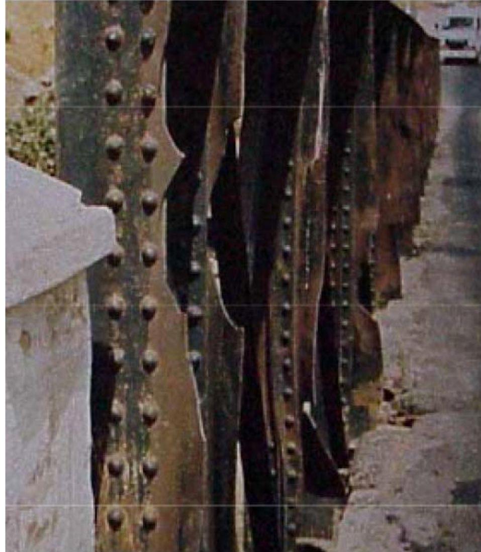
Fig. 22 : Fragilité au choc sur acier des années 1920 env.
